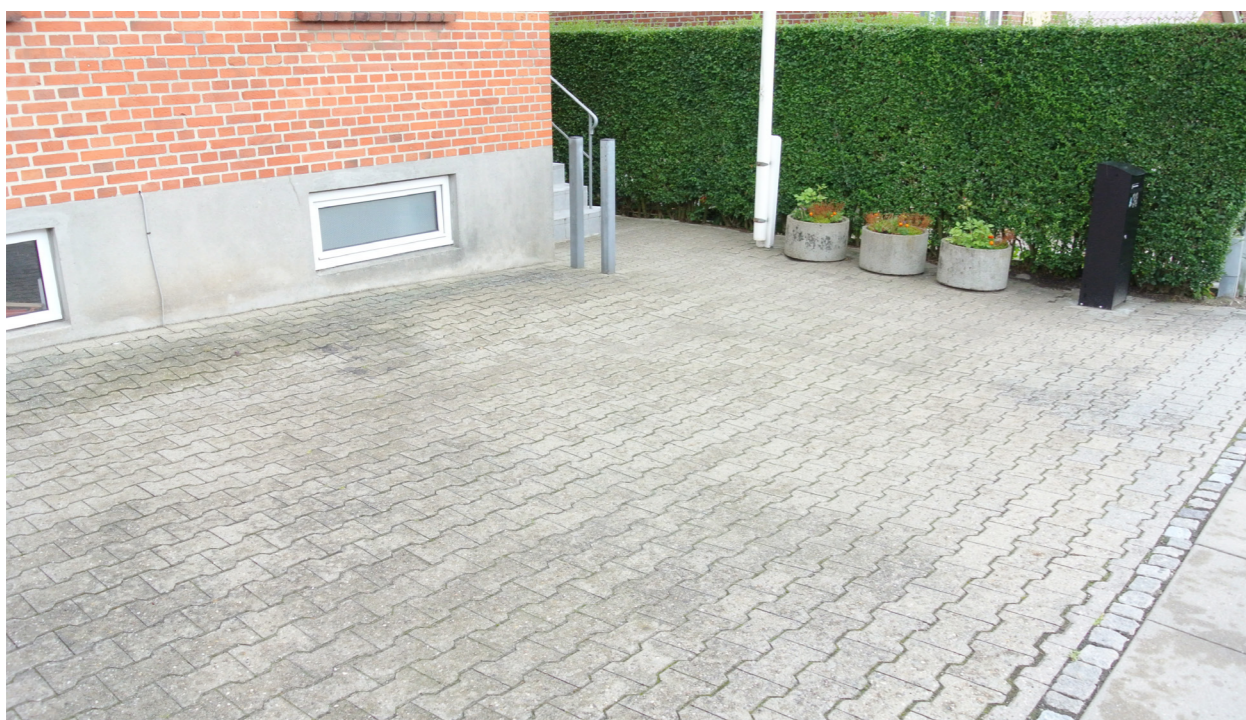
Mange private grunde har en høj belægningsgrad, der skaber meget spildevand. (Foto: Lene Alsbjörn)
